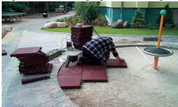
Bei der Verlegung auf unbefestigtem Untergrund kann eine geeignete Unterlage (z.B. Blech) als Installationshilfe zum Einsatz kommen, um sicherzustellen, dass die Fugen frei von Materialeinschlüssen bleiben.
