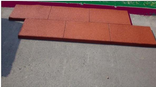
Verlegen Sie die Platten der oberen Lage mit einem geringen Versatz zu den Fugen der unteren Lage.
