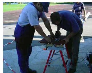
Schneiden Sie die letzte Platte jeder Reihe entsprechend der Begrenzung der Fläche mit einem hochbelastbaren Schneidmesser bzw. mit einer Stichsäge zu.
